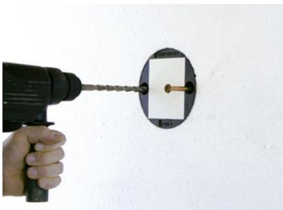
Nach dem Aushärten des Klebemörtels Schraubdübel versetzen und
