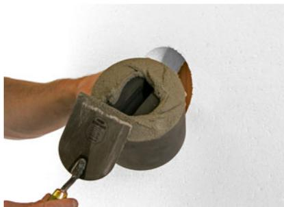
Estrarre i tappi in EPS dalla nicchia ed applicare della malta adesiva sulla superficie d'incollaggio della piastra di montaggio universale UMP®-ALU-Z. L'elemento deve essere incollato coprendo la totalità della superficie sul fondo portante.
