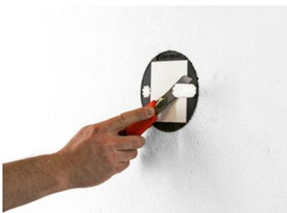
Bohrungen mit EPS-Stopfen schliessen. Mauerwerke mit Lochsteinen ohne Schlag bohren.
