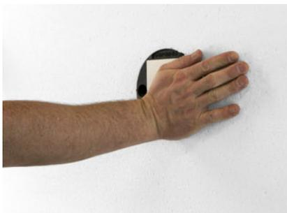
Universalmontageplatte UMP®-ALU-Z dämmplattenbündig anpressen.
