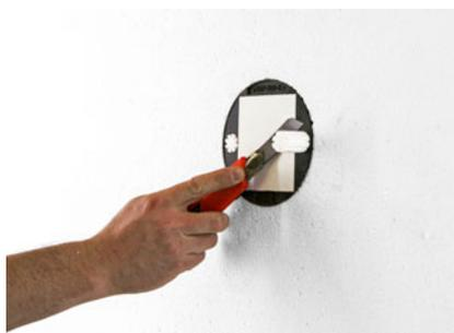
premendo, inserire le formelle in EPS. Trapanare i muri con mattoni forati senza utilizzare la funzione percussione.
