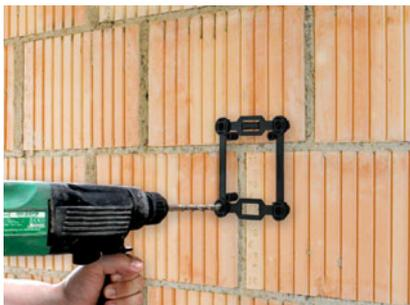
Mit Hilfe der Unterlage zweites Bohrloch bohren.
