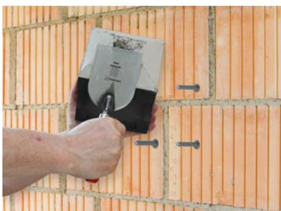
Unterlage auf Universalmontageplatte UMP®-ALU-TQ setzen.
