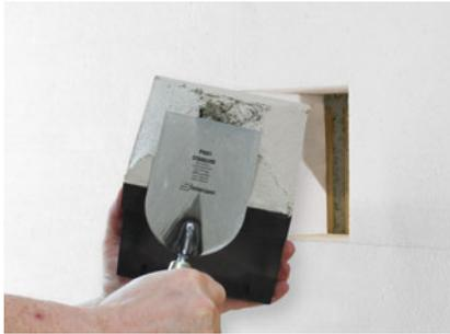
Auf die Klebefläche der Universalmontageplatte UMP®-ALU-TQ Klebemörtel aufziehen. Element muss vollflächig auf den tragfähigen Untergrund verklebt werden.
