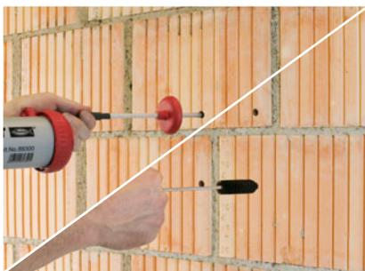
Bohrlöcher müssen gründlich vom Bohrstaub gereinigt werden.
