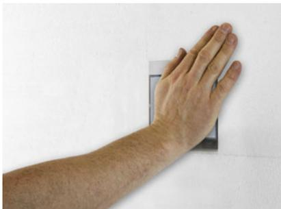
Universalmontageplatte UMP®-ALU-TQ dämmplattenbündig anpressen.
