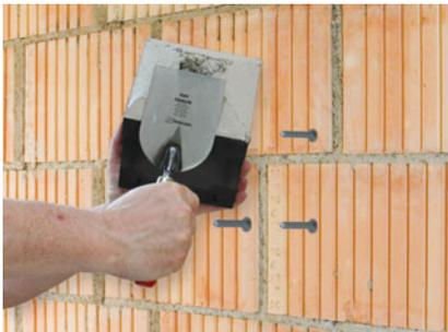
Posizionare la staffa sulla piastra di montaggio universale UMP®-ALU-TQ.
