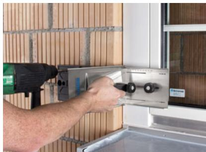
Realizzare il primo foro e inserire il perno di fissaggio al suo interno.
