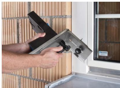
Inserire il posizionamento calibro sull'elemento di supporto cardini K1-PE.
