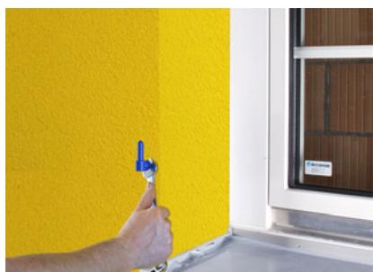
Avvitare componente nell'elemento di supporto cardini K1-PE.
