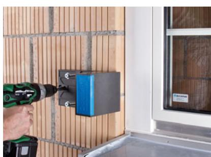
Regolare la posizione dell'elemento di supporto cardini K1-PE attraverso i piedini di regolazione in modo che sia a filo con la facciata, quindi stringere i perni di fissaggio.
