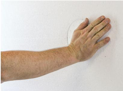
Premere il cilindro di montaggio Rondoline®-EPS a filo dei pannelli isolanti nella sezione fresata.
