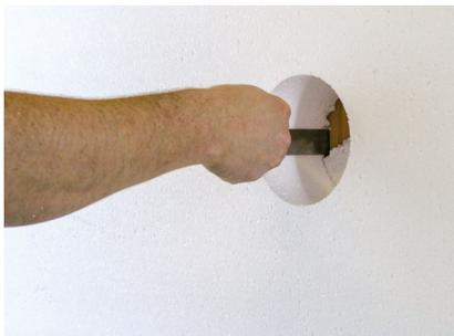
Restdicke mit geeignetem Werkzeug herauskratzen und Ausfräsung vom Frässtaub reinigen.
