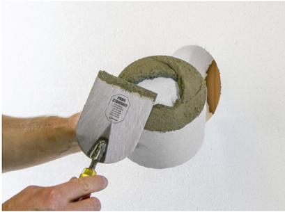
Applicare della malta adesiva sulla superficie circolare del cilindro di montaggio Rondoline®-EPS. L'elemento deve essere incollato coprendo la totalità della superficie sul fondo portante.
