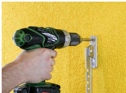
Avvitare la componente nel cilindro di montaggio Rondoline®-EPS.
