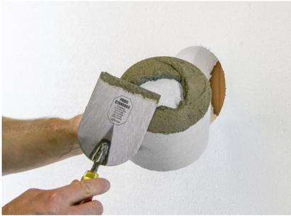
Auf die Kreisfläche des Montagezylinders Rondoline®-EPS Klebemörtel aufziehen. Element muss vollflächig auf den tragfähigen Untergrund verklebt werden.
