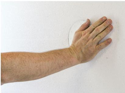
Montagezylinder Rondoline®-EPS dämmplattenbündig in die Ausfräsung pressen.
