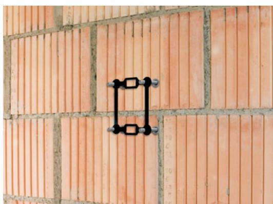
Gewindestangen setzen und durch aufstecken der jeweiligen Unterlage genau ausrichten.
