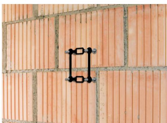
Positionner les tiges filetées et les aligner exactement en insérant la base correspondante.
