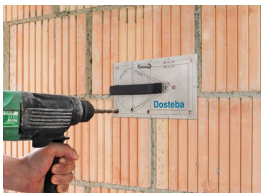
Quando si usa la dima di foratura per UMP® / TRA-WIK® / TWL®, inserire un aste filettate nel foro corrispondente.
