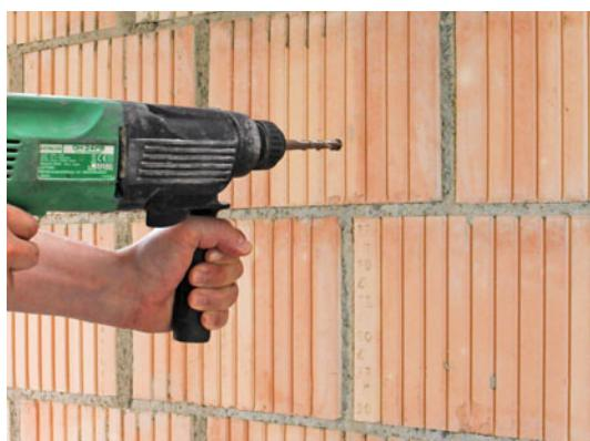
Erstes Bohrloch anzeichnen und bohren.
