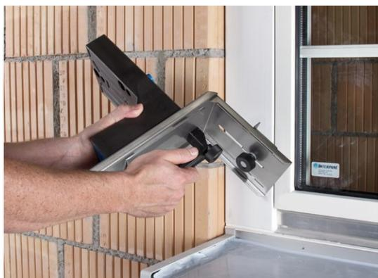
Setzlehre auf Klobentragelement K1-PE, K1-PU oder Tragwinkel TRA-WIK®-PU aufschieben.
