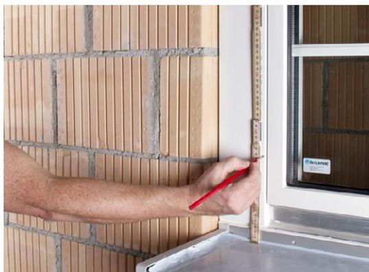
Il est recommandé de poser les éléments pour fixation des gonds K1-PE, K1-PU et equerres TRA-WIK®-PU avant de coller les panneaux isolants.
